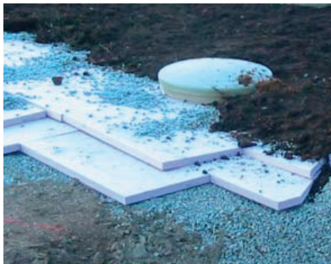
Frostsikring av tanker
