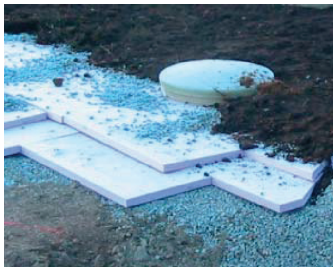
Frostsikring av tanker
